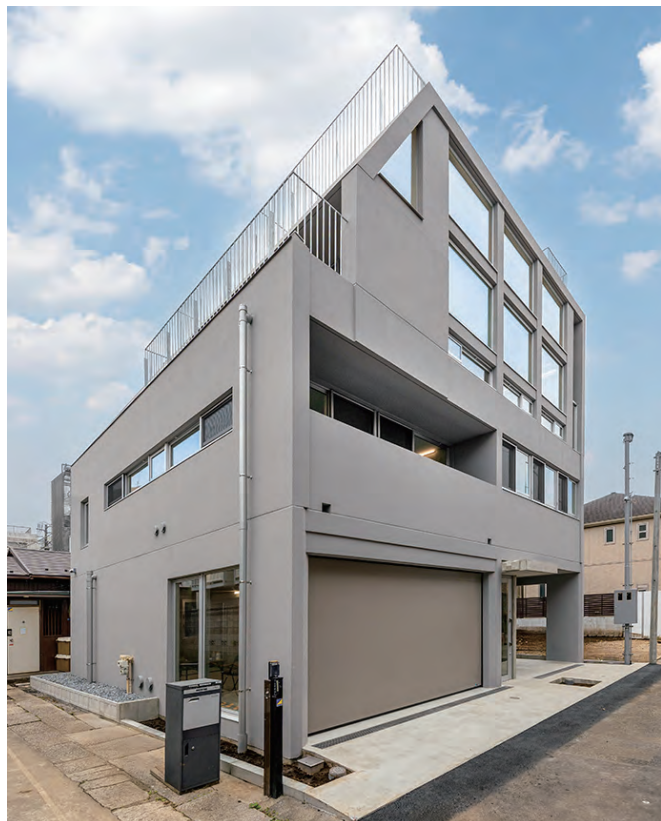
建物全景。断熱塗料を施した外壁
