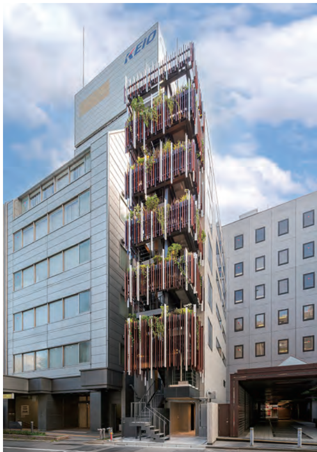
建物全景。ランダムに設置された L 形アングルルーバーが目立つ
