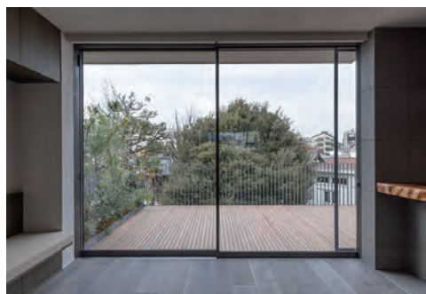
3階バルコニーへは細フレームサッシ開口からアクセス
