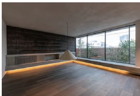
3階リビング。ベンチは躯体と共に打設強度を確保
