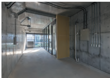
2階テナント内部
