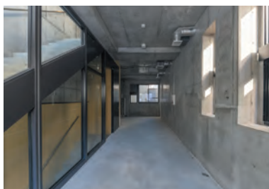
1階テナント内部
