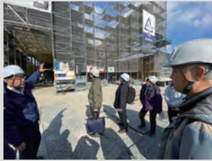
麦島建設 作業所所長 中村様の説明を受けてから場内見学へ
