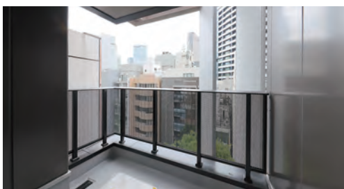
10階バルコニー。ルーバーに角度をつけ、陽の光の入り方を調節
