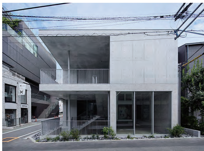
南側全景。吹き抜けを通して対角側へ視線が抜ける
