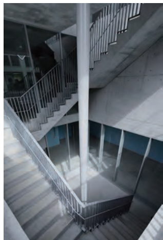
1階から地下階への階段室
