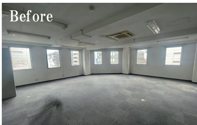
改修前の室内
