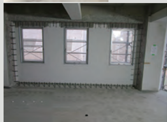
あと打アンカー施工後
