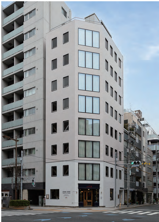
改修工事後の建物全景。明るくなった外装が青空に映える
