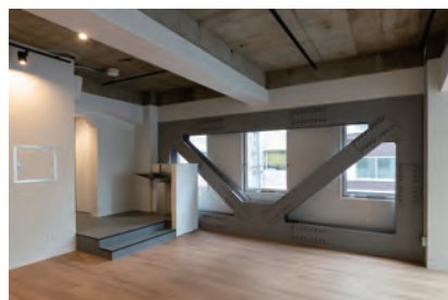
内部空間には耐震構造を設けた
