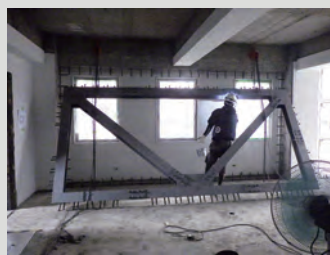
制震ブレース建方
