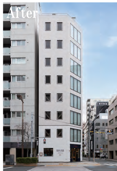
タイル補修後、塗装を施し明るい印象に
