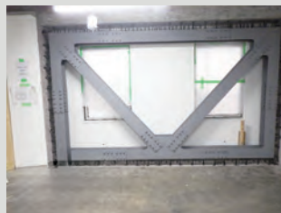
制震ブレース設置完了
