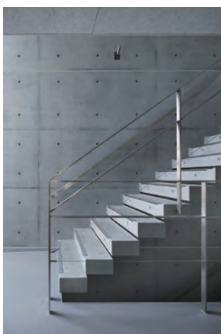
閉塞感のない目透かしを入れた階段
