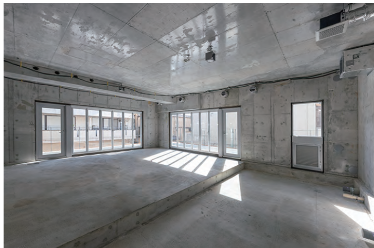
2階テナントスペース。飲食店を想定した広々空間。
