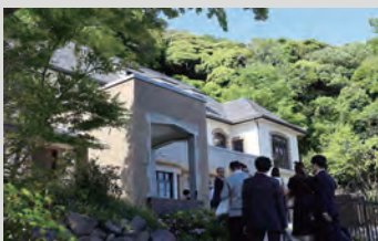
改修工事後の「日本多邸」全景
