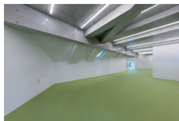
3階貸室。多角形屋根を支える梁が特徴
