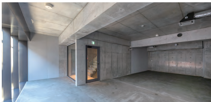
2階テナント内部
