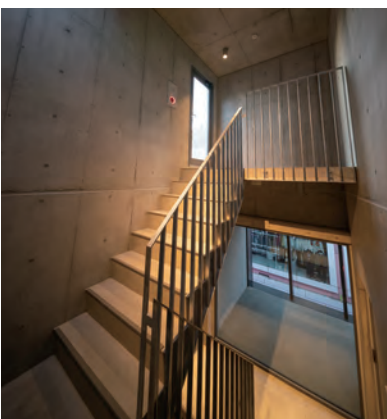
屋上につながる階段室
