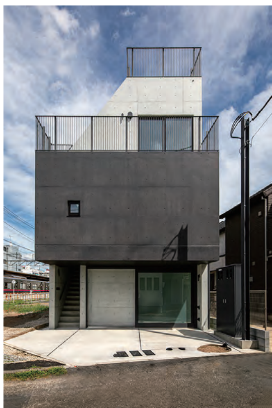
建物西面。外壁面と手摺仕上げ面が綺麗に揃う
