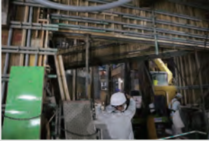
地下1階の型枠・配筋
