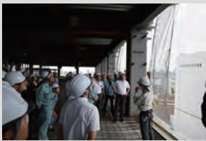
高層階は厳重な落下防止対策
