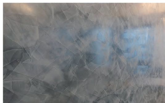
スタック仕上げの壁。金ペラで模様付け後、磨き上げて鏡面に
