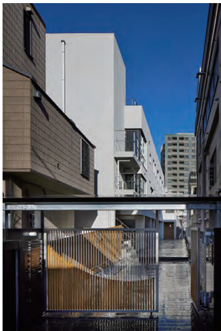
エントランスゲート
