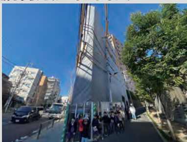
(仮称) 三田 418 プロジェクト全景
