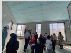
天井には別の断熱材を敷き詰める
