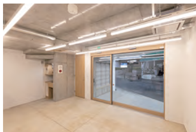
建て主様が使用予定の1階スペース
