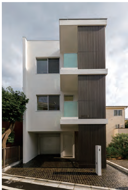
木製ファサードが印象的な建物全景
