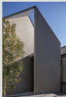
『空のある音楽ホール』 建物全景
