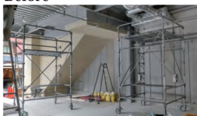
1階施工中。LGS組立作業中
