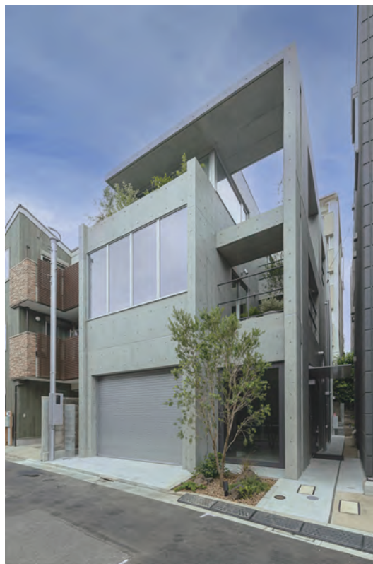
建物全景。シャープな外観
