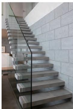
階段。フィルムをガラスで挟むことで強度が増したガラス手摺を設置
