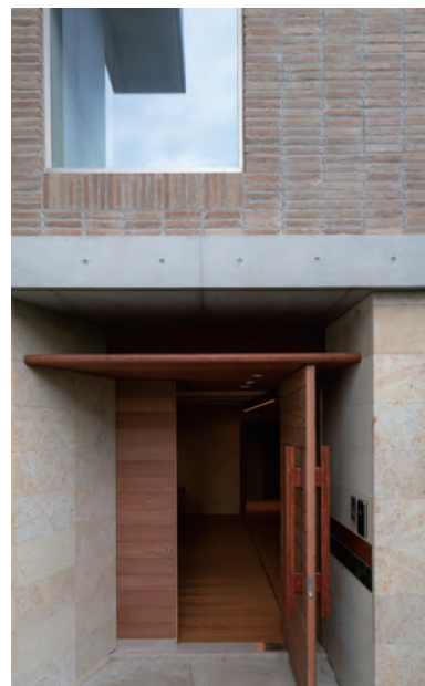
アプローチから玄関扉を見る
