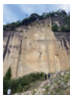
小松市観音下（かながそ）の石切場。垂直に切り出された岩肌が庄巻だ。最近では黄色味がかった石は採石困難になりつつある
