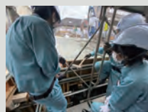
打設後型枠を叩くことで空気を抜く
