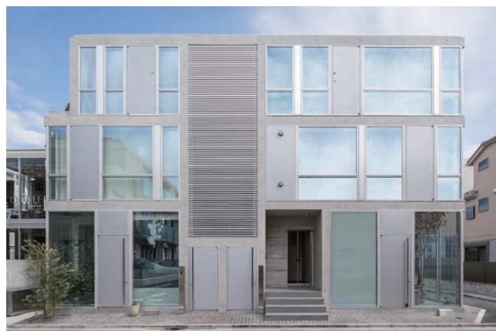
南側ファサード。中央、ルーバーを設けた半戸外の階段の両側に店舗
