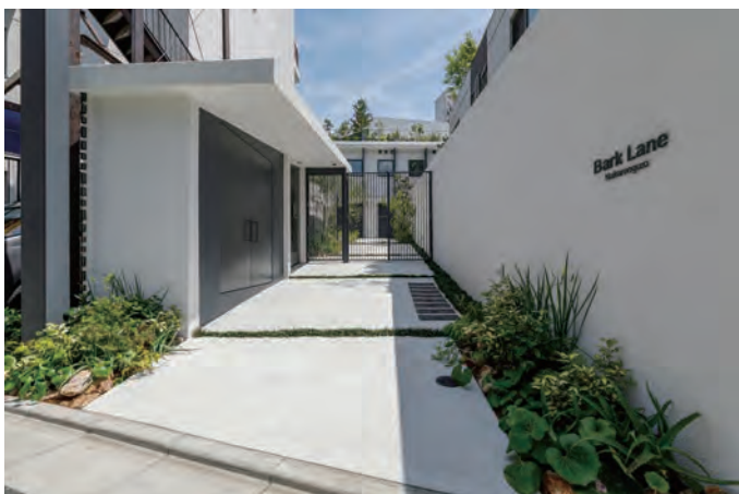
前面道路よりアプローチを臨む。ゲートが設けられセキュリティにも配慮
