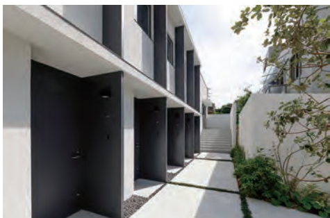
北側より各住戸の入口アプローチを望む
