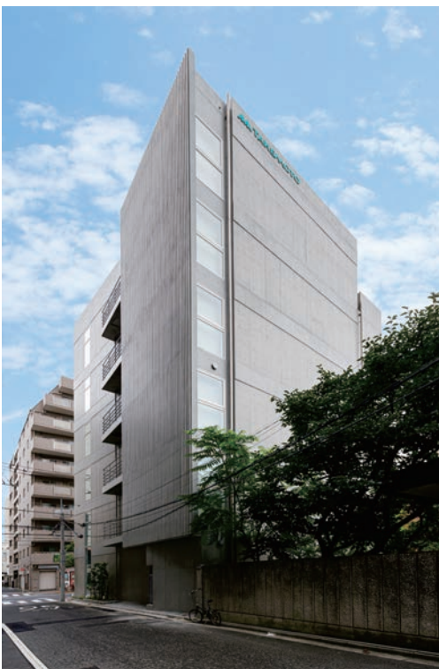
西側外観。薄く茶色をいれた外壁に各階ごとにグレーの帯を設けることで変化をつける
