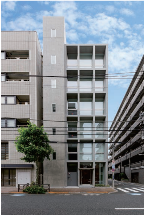
東側外観。格子状のコンクリートによって排煙の法規解決を図ることで、開放的な外観をつくっている
