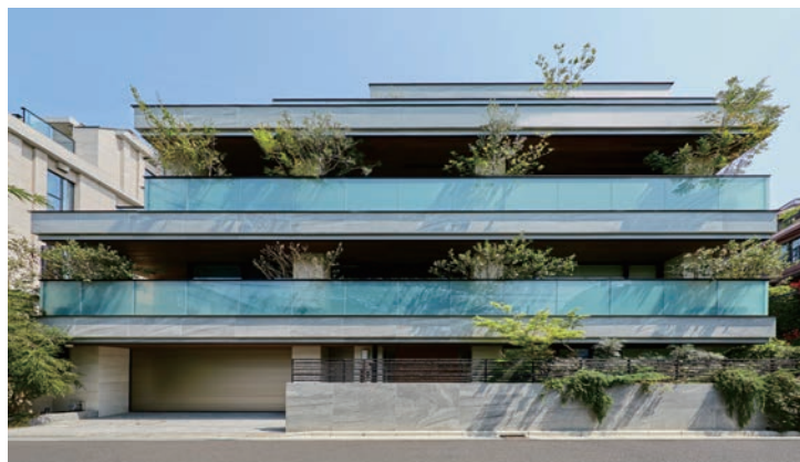
西側ファサード。深い庇が外からの視線を遮り、フロストガラスのテラスとグレーの外壁の間から適度な光が室内に差し込む。豊かな植栽が建物を彩る
