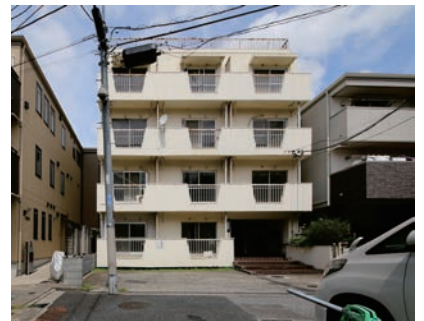
再生前全景。コンクリートの手摺が付いていたバルコニー
