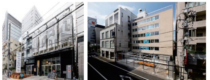
辰で耐震改修工事を担当した「100BANCHO」(写真左)と「オクシビル」(写真右)
