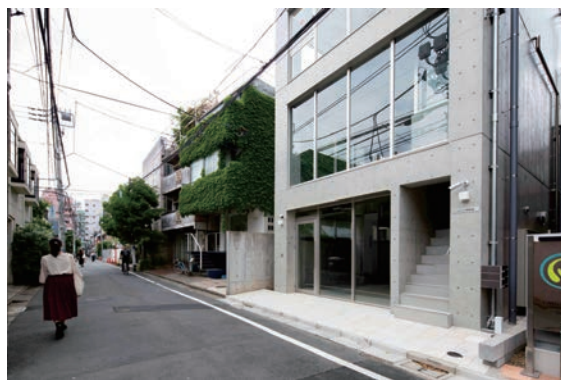
北西側全景。青山通りから入った住宅街に建つ
