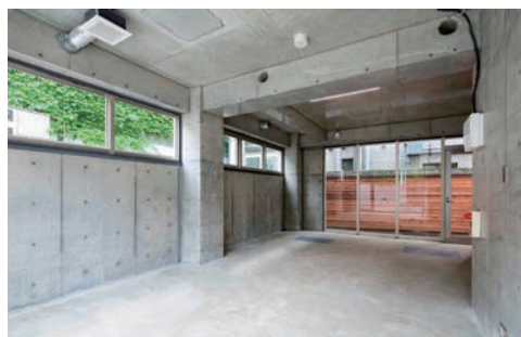
1階。突き当りに木の壁、東側上部に開口部
