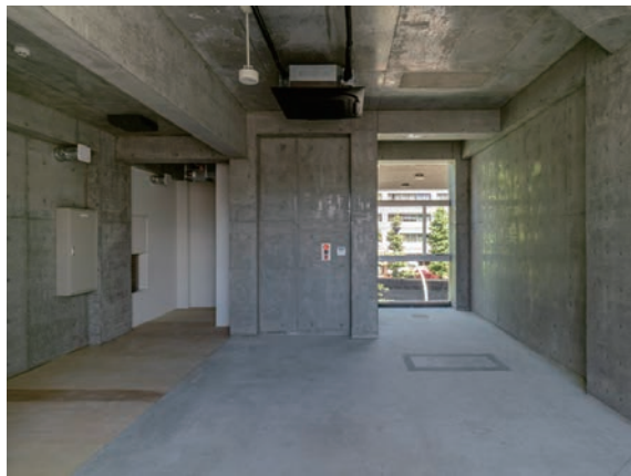
3階。高い天井高、左側奥に内断熱材の石膏ボードが貼られている
