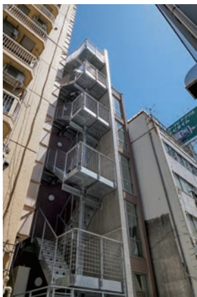
南側外観。窓周りに薄いあづき色のエコサームが見える
