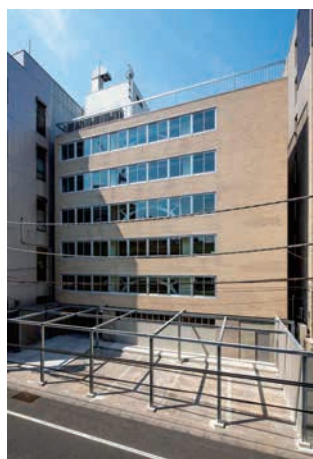
外壁タイルは生かし、建物前面にパーゴラを設けた
