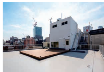
屋上。デッキを敷き、憩いの空間に
