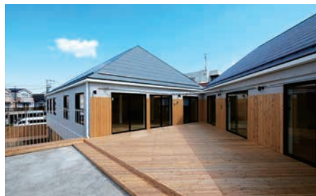
2階。A棟とB棟前のデッキ
