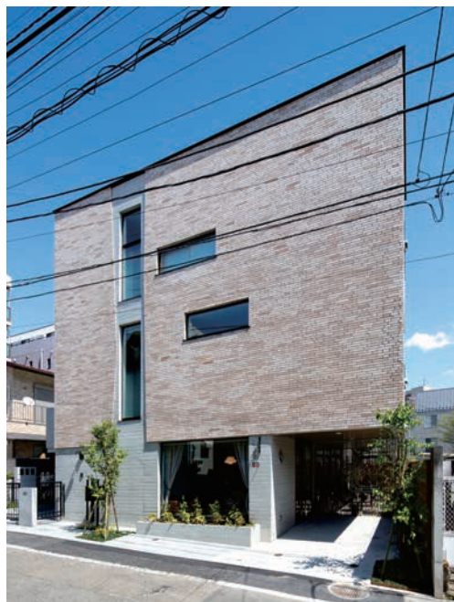
全景。打ち放しコンクリートに珪器質タイルが柔らかさを加える。開口部廻りの納まりは「折形」から着想を得た
