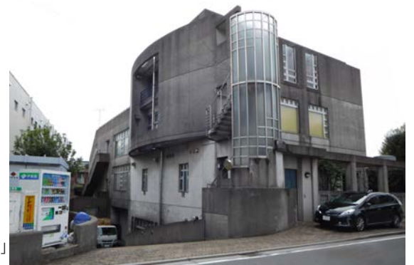
改修前の、「高山商店」 北側全景写真
