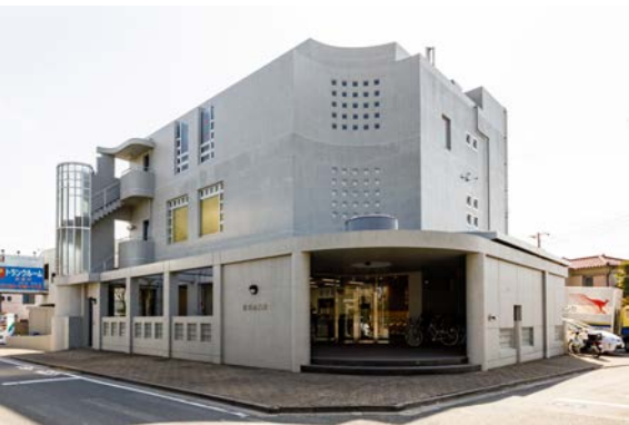
建物北西側全景。工場・事務所入口。角を R に落とし、趣のあるアプローチ
