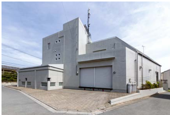
建物西側全景。シャッターのあるところが、トラックを横付けできる配送のスペース
