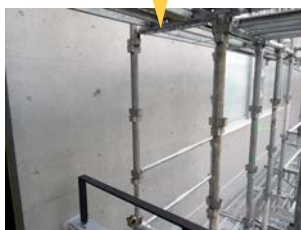
同じく東側。鉄筋の露出が見られ、下地処理、左官屋さんによる整形を済ませて、TC工法で化粧補修
