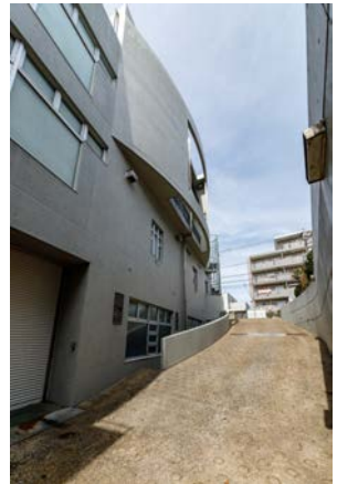
東側スロープ。地下の工場への運搬作業はこちらから
