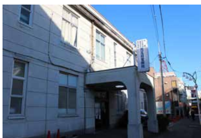
建替え前の建物。 左：東側全景 右：建物内、診察室廊下
