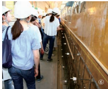
⑥普段は見られない型枠パネルやPコン、鉄筋などが一望に。北棟共用廊下
