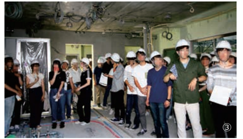
③2階ではバスユニットが入り、各種配管が床を走る。3階では壁に引かれたFL,SLなど線の意味も再確認
