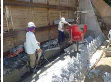
⑥⑦砂利敷き、コンクリート打設、石積みの繰り返し。石積みは宍戸石材工業
