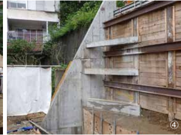
④袖壁は横座屈防止にC型鋼を張っている
