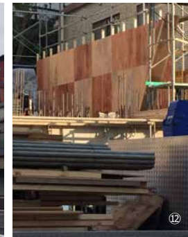
⑫コンクリート打ち放しの型枠のラワン合板は、タイ産、マレーシア産、日本の秋田産
