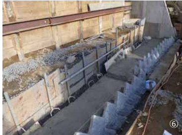
⑥⑦砂利敷き、コンクリート打設、石積みの繰り返し。石積みは宍戸石材工業
