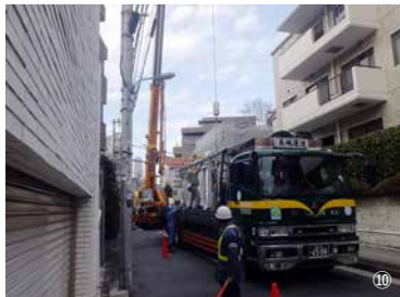
⑩ブリッジは、10tトラックで搬入。
