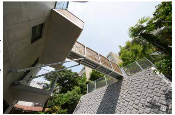
完成したブリッジと擁壁 (写真：阿野太一)
