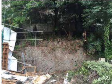
②既存擁壁は解体
