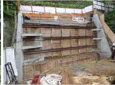
③山留の鋼材を打ち込み、頭繋ぎ3段を作る
