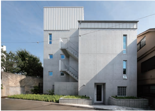
建物北側外観。中原街道と反対側の高台の方が建物入口となっている
