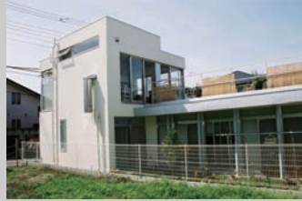
空き地から見た建物南景
