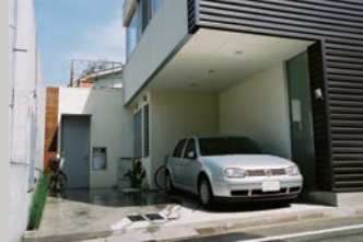
西側エントランス
