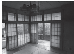
改修前の2階和室
