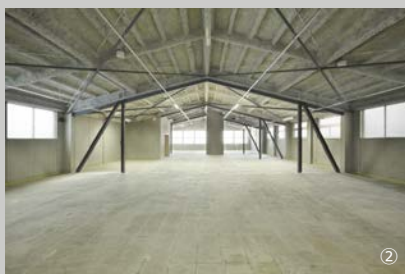
①建物全景。ファサードの2、3階にバルコニーを設置②3階は梁下に耐震補強を行い、横方向のスパン割で排煙の区画を確保③3階は鉄骨の柱とブレースで耐震補強した。1、3階は窓を追加し、排煙面積を確保
