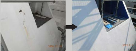
塔屋外壁北面：過去の補修箇所が再び破損していた
