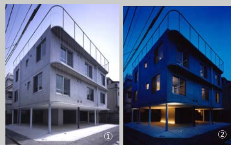
「N」W棟 竣工撮影：新良太
