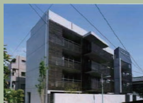
「二軒家アパートメント」 (2003年竣工) 外壁コンクリート打ち放し部分、屋上、ルーバー等のリニューアル工事を行いました。コンクリートの力強さが蘇った感じでした。
