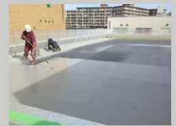
トップコート塗布状況
