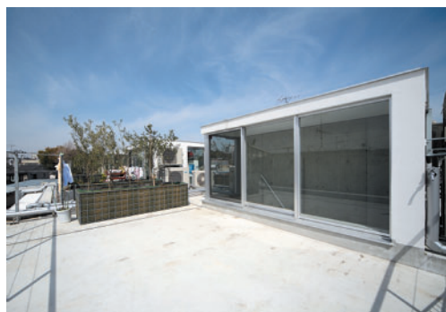
②F住戸屋上。プランターが置かれた隣家との仕切りは緩やか。
