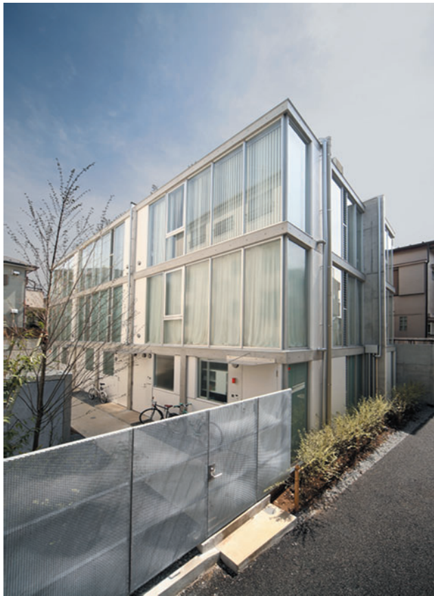
①西側外観。手前の私道はもともと暗渠だったところを、区がアスファルトの遊歩道に。エキスパンドメタルの塀で通風もよい。建物の2階は住民の要望により、視線を遮るすりガラス、3階は普通の透明ガラスを採用。機械式駐車場は3台分。名前の「Glasfall」はドイツ語で「ガラスの箱」という意味。
