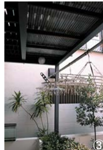
①2階ダイニングからリビングへの通路。1年ほど前に壁は水性塗料を塗りなおしている②同じく2階ダイニング側を臨む。竣工当時の床の色はもっと濃かったが日の当たる部分は色味が抜けてきている③1階テラスの物干しコーナーには、上のデッキの隙間からホコリが落ちるので、簡単な屋根として透明な波板をデッキの下に設けた④飼い犬のサキちゃんが建具に足をかけるので疵がついている⑤地下の中庭。夏は涼しく、採光にも癒し空間としても非常に機能している。
