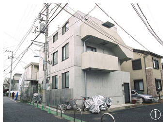
①現在の全景。洗浄したため、竣工時と外壁の美しさは変わらない②2階南側の薪ストーブのための煙突。現在は使われていない。コンクリートの設置穴の廻りを埋めたコーキングに少しひび割れが見える。
