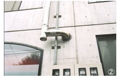
①現在の全景。洗浄したため、竣工時と外壁の美しさは変わらない②2階南側の薪ストーブのための煙突。現在は使われていない。コンクリートの設置穴の廻りを埋めたコーキングに少しひび割れが見える。
