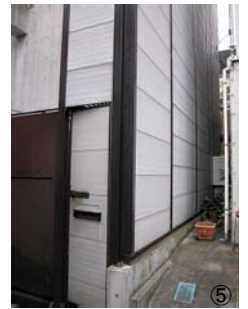
①1階天井にあげられた空調機の点検口。ステンレスの孔版を貼って目隠しをしているが、ビスの穴が抜けやすいので、毎回違う穴を作ってしまう。②地下1階のテラスへの扉が開閉時に床を擦る。大型の扉のため調整がむずかしい。③同じく地下1階。バーのカウンター側の壁に雨漏りが見つかリ、以後応急的に対応しているが原因不明。目隠しにすだれをかけている④外部階段の白華現象。⑤従業員通用口側の外壁は、近隣の要請により、竣工当初に押出成形セメント板の防音壁を新たに作った。
