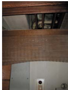
①1階天井にあげられた空調機の点検口。ステンレスの孔版を貼って目隠しをしているが、ビスの穴が抜けやすいので、毎回違う穴を作ってしまう。②地下1階のテラスへの扉が開閉時に床を擦る。大型の扉のため調整がむずかしい。③同じく地下1階。バーのカウンター側の壁に雨漏りが見つかリ、以後応急的に対応しているが原因不明。目隠しにすだれをかけている④外部階段の白華現象。⑤従業員通用口側の外壁は、近隣の要請により、竣工当初に押出成形セメント板の防音壁を新たに作った。
