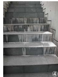
①1階天井にあげられた空調機の点検口。ステンレスの孔版を貼って目隠しをしているが、ビスの穴が抜けやすいので、毎回違う穴を作ってしまう。②地下1階のテラスへの扉が開閉時に床を擦る。大型の扉のため調整がむずかしい。③同じく地下1階。バーのカウンター側の壁に雨漏りが見つかリ、以後応急的に対応しているが原因不明。目隠しにすだれをかけている④外部階段の白華現象。⑤従業員通用口側の外壁は、近隣の要請により、竣工当初に押出成形セメント板の防音壁を新たに作った。
