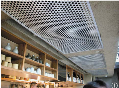
①1階天井にあげられた空調機の点検口。ステンレスの孔版を貼って目隠しをしているが、ビスの穴が抜けやすいので、毎回違う穴を作ってしまう。②地下1階のテラスへの扉が開閉時に床を擦る。大型の扉のため調整がむずかしい。③同じく地下1階。バーのカウンター側の壁に雨漏りが見つかリ、以後応急的に対応しているが原因不明。目隠しにすだれをかけている④外部階段の白華現象。⑤従業員通用口側の外壁は、近隣の要請により、竣工当初に押出成形セメント板の防音壁を新たに作った。
