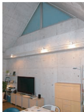
現在の9階オーナー邸の西側の内壁（撮影：編集部）
