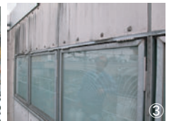
①4階バッファゾーン。天井によしずを置いている②4階除湿タワー。③4階外部キャットウォークの壁のシールを補修した箇所。
