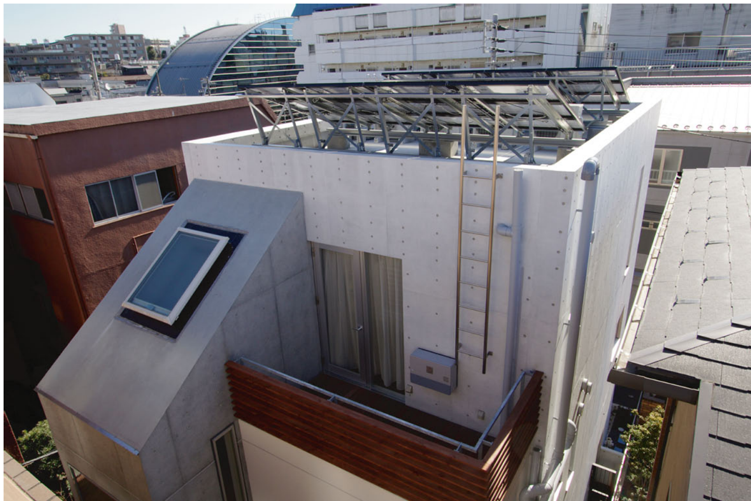
N-HOUSE 太陽光発電装置と換気、調湿、熱回収機能を有するシャフト 撮影：佐藤信太郎
